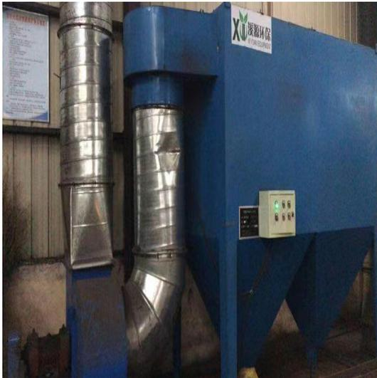
图 3-1 切割下料工序脉冲滤芯除尘器
