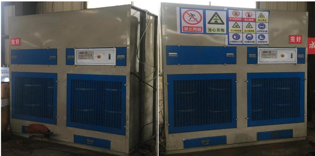
图 3-3 打磨工序干式除尘柜
